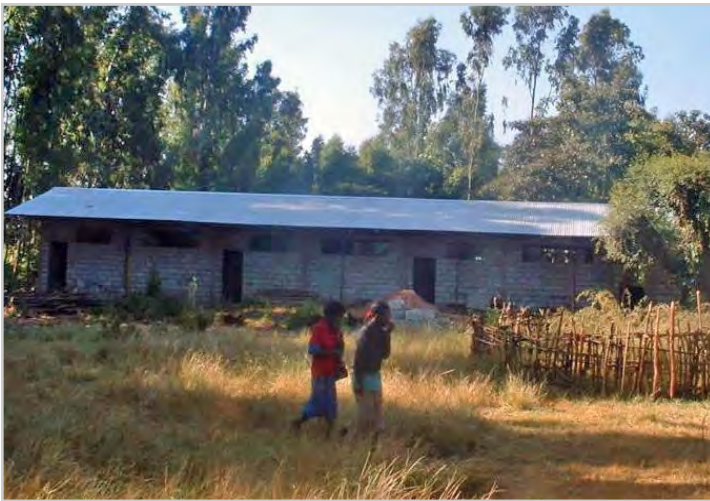
Rohbau der Partnerschule
